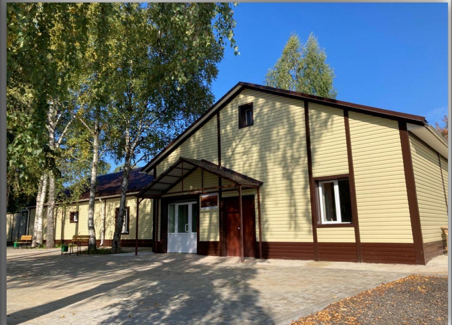
Здание общественной бани
